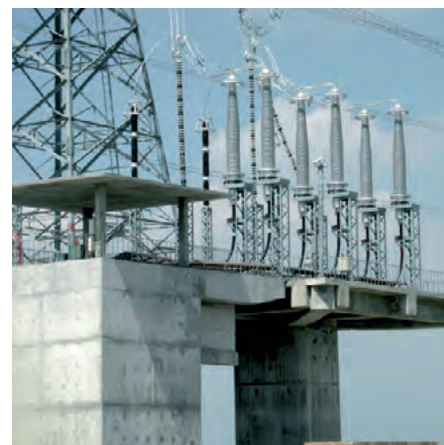
Tainan – Kabelendverschlußgerüste auf einer hochwassergeschützten Plattform.
