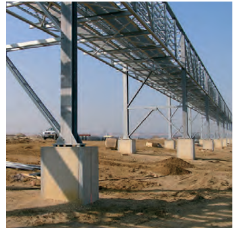
Kabelbrücke im Tagebau Garzweiler.
